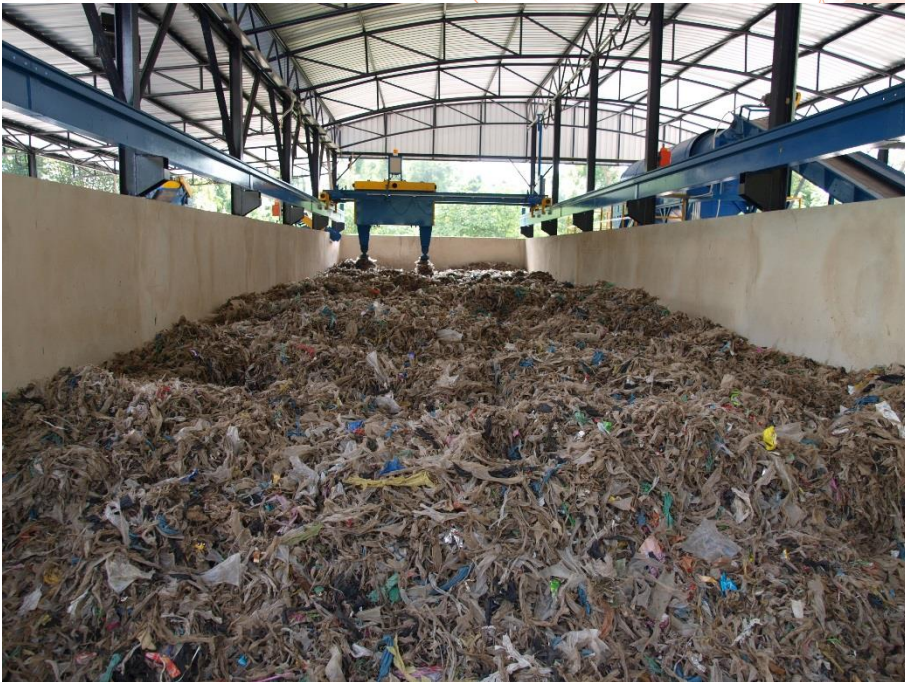
โรงงานบำบัดทางกลและชีวภาพ (Mechanical and Biological Treatment: MBT)
