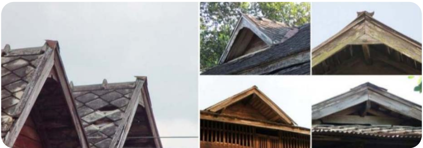
ปลายจ้องแบบไม่ประดับตกแต่ง (สืบพงศ์ จรรย์สินศรี, 2559, น.38)
