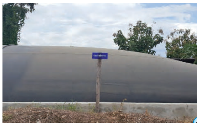
ภาพที่ ๕๗ - ๕๘ ระบบผลิตก๊าซชีวภาพและบำบัดน้ำเสียจากมูลสุกรภายในฟาร์ม ของณิชาและภาวิณห์ฟาร์ม
