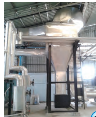
ภาพที่ ๕๓ - ๕๔ ระบบหม้อไอน้ำจากน้ำมันเตาเป็นเชื้อเพลิงชีวมวล (BIOMASS) ในการลดการปล่อยก๊าซมลพิษออกสู่สิ่งแวดล้อม ของบริษัทโรงแป้งพรกมล จำกัด
