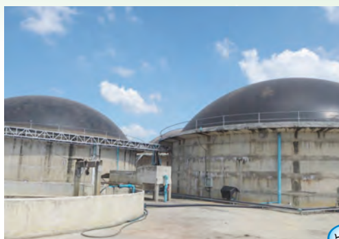
ภาพที่ ๖๑- ๖๒ ระบบผลิตก๊าซชีวภาพและบำบัดน้ำเสียจากมูลสุกรภายในฟาร์ม ของบริษัท เอส พี เอ็ม อาหารสัตว์ จำกัด
