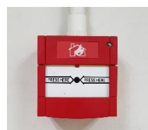
ปุ่มกดกริ่งสัญญาณเตือนภัย
