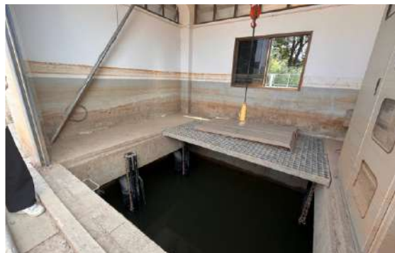
ระบบไฟฟ้า เครื่องสูบน้ำ และอุปกรณ์เครื่องจักร ได้รับความเสียหายไม่สามารถใช้งานได้
