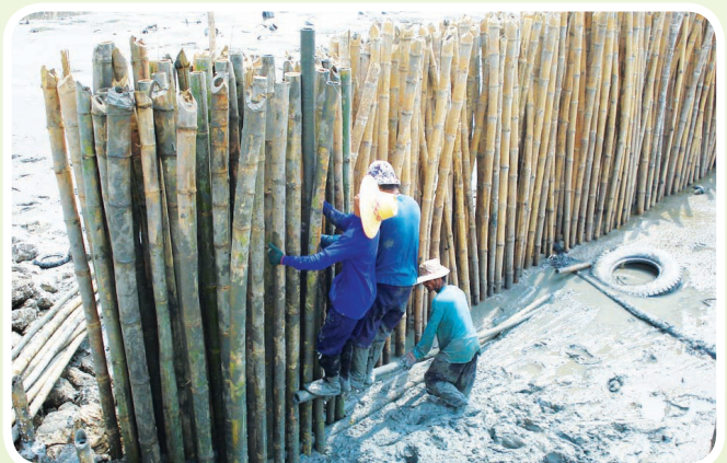
การปักไม้ไผ่ เพื่อป้องกันการกัดเซาะชายฝั่งโดยเครือข่ายรักษ์อ่าวไทยตอนบน ที่มา: คุณวรพล ดวงล้อมจันทร์
