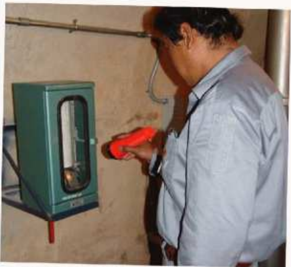
■ เครื่องวัดปริมาณการรั่วซึมของน้ำ / Seepage
